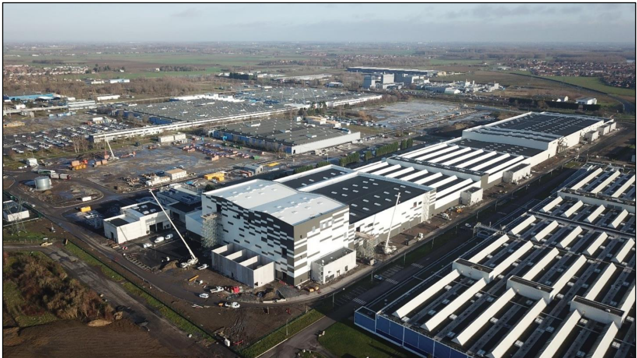
↔ Illustration : gigafactory de batteries pour véhicules électriques en construction dans le nord de la France.
